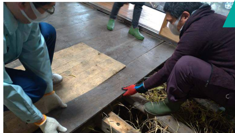
床板をはがして
